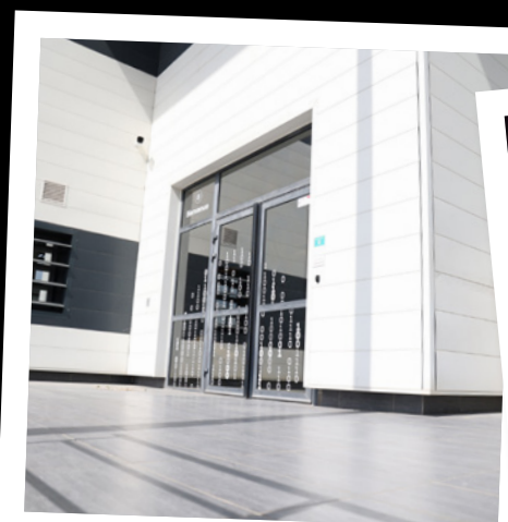
2013 : Inauguration du datacenter à Marseille
