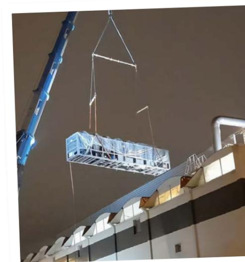
Installation en Mars 2023, du troisième groupe froid du datacenter de Marseille, permettant un fonctionnement en free cooling.
